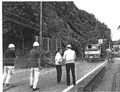
萩市椿東（中の倉） 土砂崩れ災害発生
